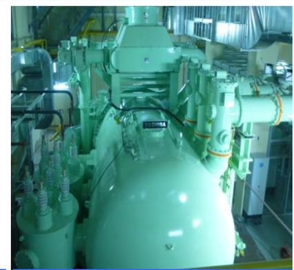
Трансформатор с газовой изоляцией, установленный в Сколково, март, 2013 г.
