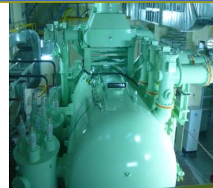
Трансформатор с газовой изоляцией, установленный в Сколково, март, 2013 г.
