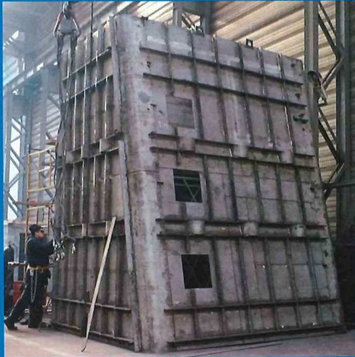
HRSG Diffuser Dzhubginskaya TPP
